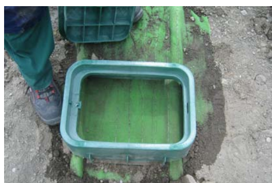
Inspekční šachta - kontrola vlhkosti rohože - VB1419 nebo VB910
