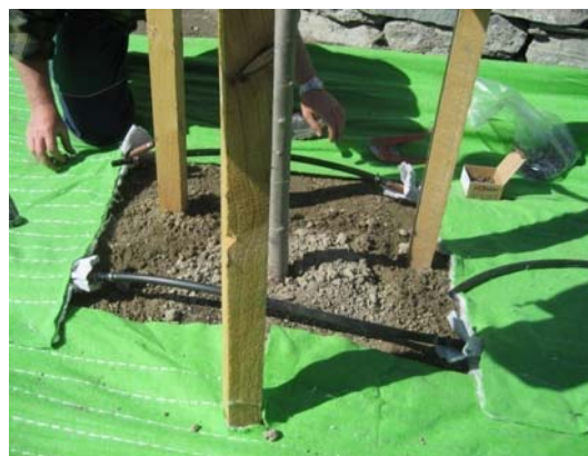
Instalace s doporučeným překryvem (cca 8-10cm) zajistí rovnoměrný spon linek á 35cm
