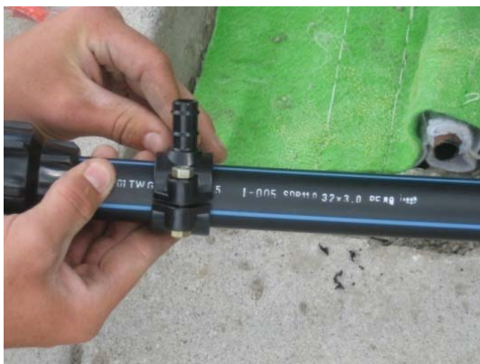
Připojení přívodního potrubí PE pomocí navrtávacího pasu s nástrčným konektorem
