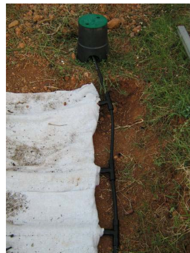
Vypouštěcí potrubí s kontrolním/vypouštěcím ventilkem na konci ventilové šachtičky (VB708)
