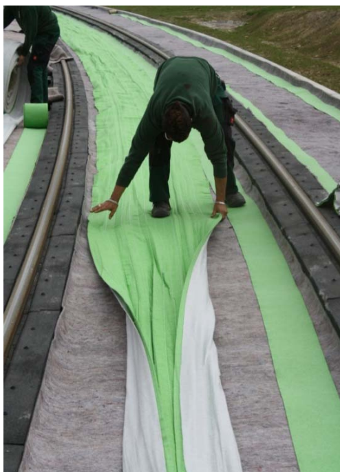
Rozkládání přeložené rohože Root Zone
