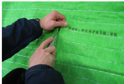
Řezání menších částí rohože rezačkou na koberce
