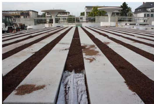
Řezání standardní rohože na dva pásy široké 40cm - speciální aplikace
