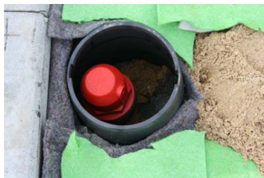
Přivzdušňovací ventil v šachtě - VB1419 nebo VB910
