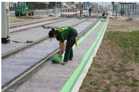
Doplnění celkové šířky s dodatečnými pruhy rohože na potřebný rozměr
