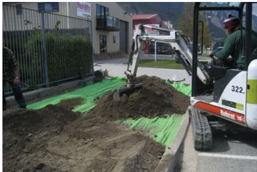
Rypadlo s nakládací/rovnací lžící / NEVJÍŽDĚT NA ROHOŽ !!
