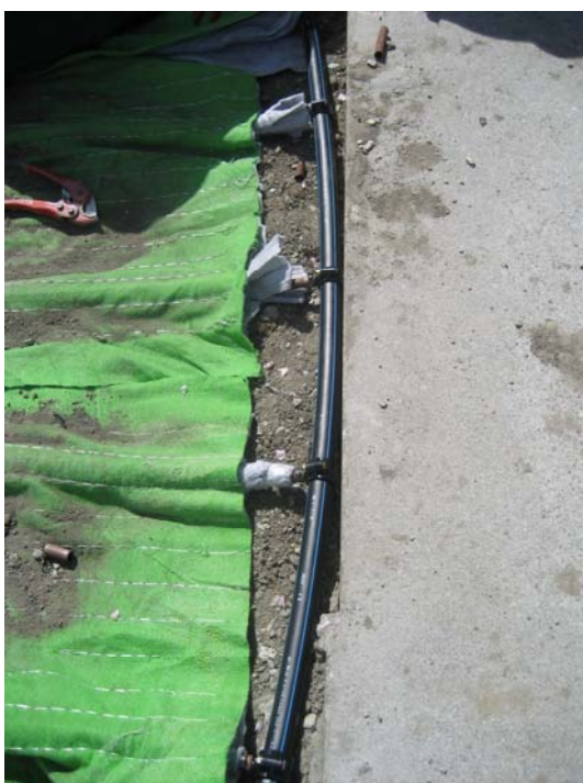
Připojení přívodního potrubí PE pomocí JEDNOSTRANNÉHO navrtávacího pasu s nástrčným konektorem
