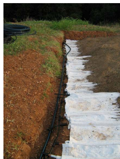
Připojení přívodního potrubí PE pomocí OBOUSTRANNÉHO navrtávacího pasu s nástrčnými konektory
