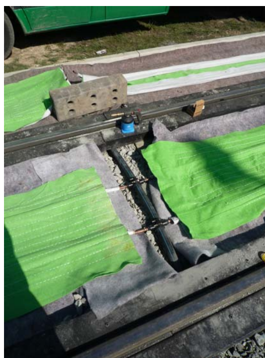
Připojení přívodního potrubí PE pomocí OBOUSTRANNÉHO navrtávacího pasu s nástrčnými konektory
