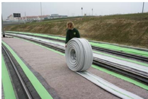
Rozbalování rohože Root Zone
