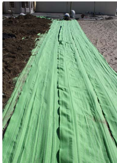
Instalace s doporučeným překryvem (cca 8-10cm) zajistí rovnoměrný spon linek á 35cm
