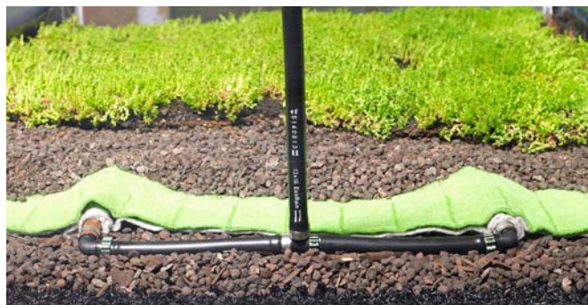
Instalace rohože Root Zone u půdopokryvných rostlin a štěrkové drenážní vrstvy (potrubí ve středu obrázku bude samozřejmě sklopeno do vodorovné polohy).
